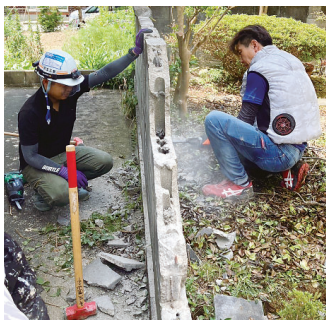
ブロック塀の解体
